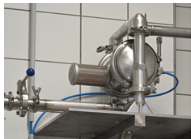
FLUX Druckluft-Membranpumpe SD20 im Hygiene Design
